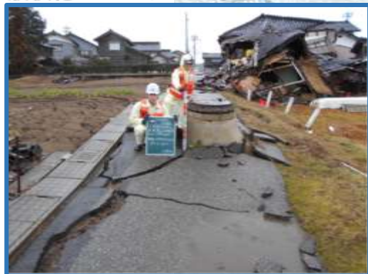
液状化・マンホール浮上
