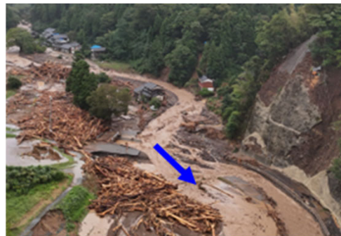
塚田川における人家流失・流 木阻害(石川県輪島市)
