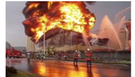
石油タンクの全面火災（2003年十勝沖地震）
