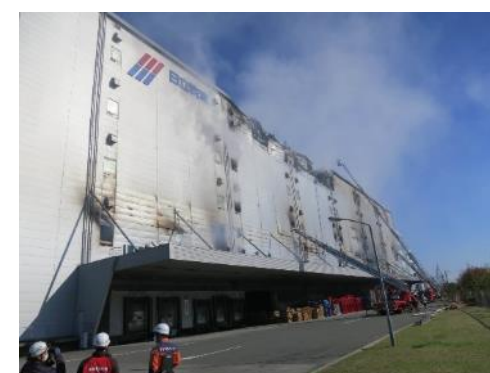
大阪市倉庫火災 (令和3年12月)
