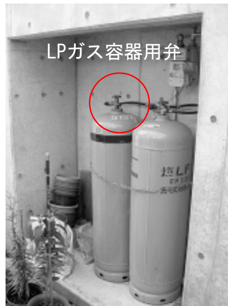
LPガス容器の設置の例
