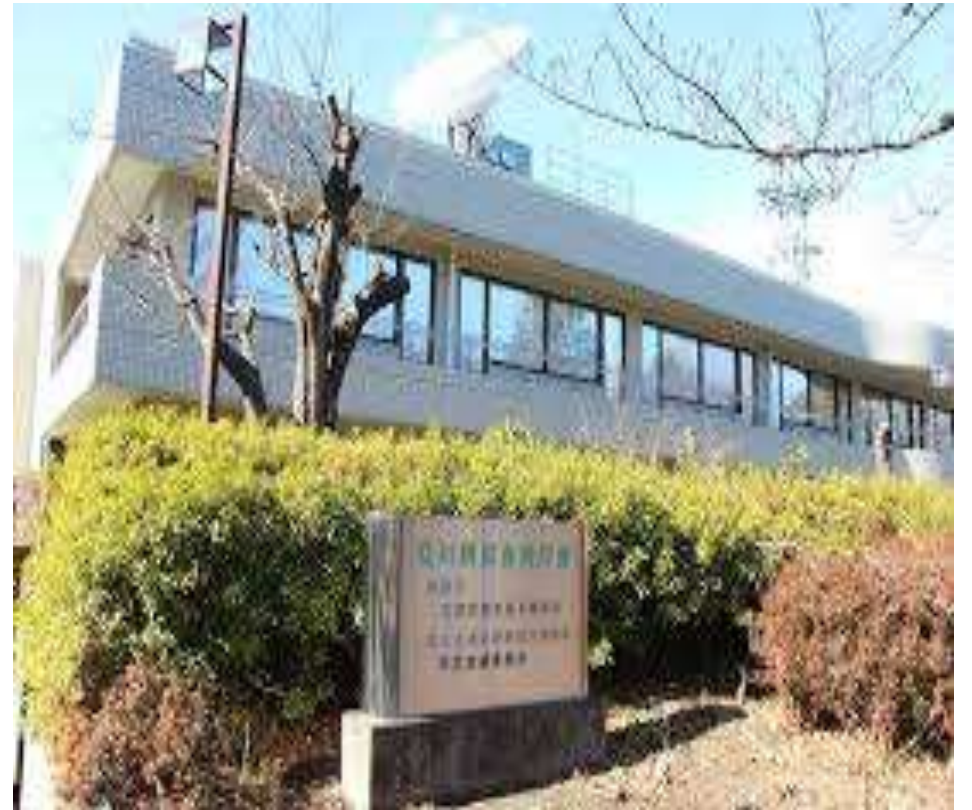
立川防災合同庁舎
