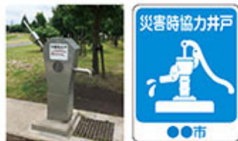
防災井戸（災害用井戸）と標識（例）
