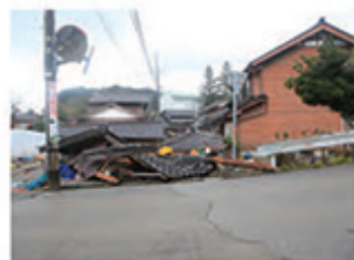
能登半島地震の住宅被害の様子
