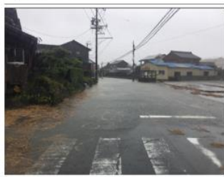
投稿内容: 河川管理情報(河川状況) 堤防崩壊 20cm泥水 報告地点: 三重県伊勢市桑名町 投稿日時: 2019-10-12 09:57:57
