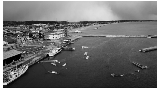
図7 ドローン空撮による珠洲市飯田港の様子
