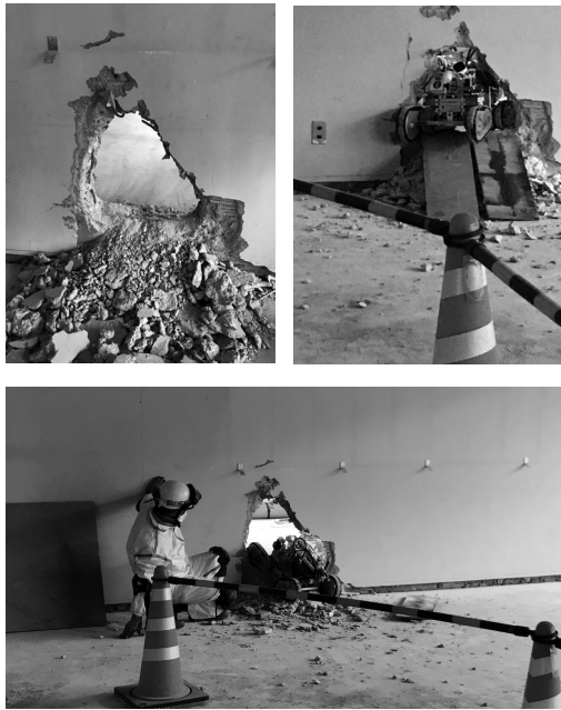
図 6 左 ブリーチング開口部，右 ロボット帰還時の様子，下 ロボット進入時の様子
