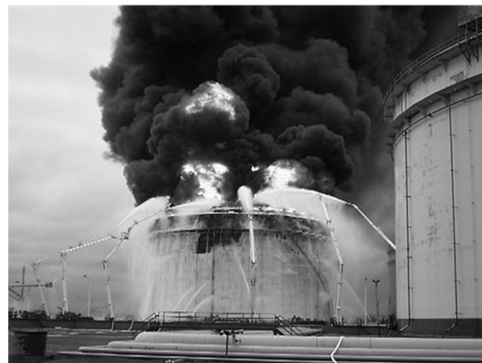
図3 2003 年十勝沖地震でのタンク全面火災(消防研究センター撮影)
