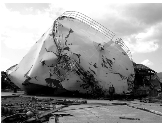
図4 2011年東北地方太平洋沖地震で移動・損壊したタンク（著者撮影）
