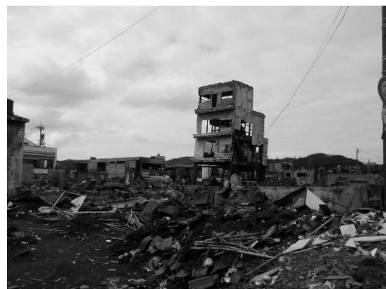
図1 輪島市河井町の火災現場
