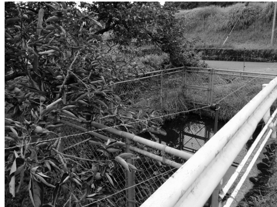
図4 集落の空地につくられた防火水槽
