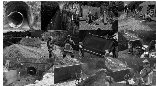
図 8 訓練の様子 (2023.2.15) : 豊田市平和町地内旧安永川第4トンネル
