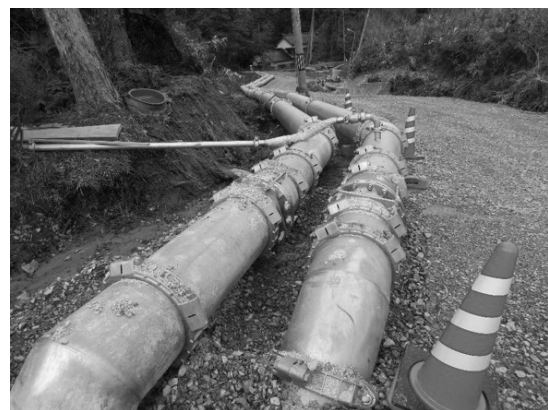
図3 輪島中学校横の道路に仮復旧された送水管・配水管
